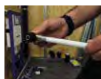
Assemblage d'un raccord MasterFix 90° avec tube Geberit Volex
