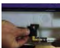
Montage d'un raccord MasterFix sur l'arrivée d'eau de bâti-support pour WC en 1/2".
